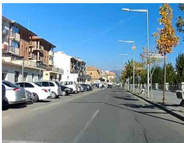
Tram amb aparcament, arbrat i mobiliari urbà (tram Sud)
