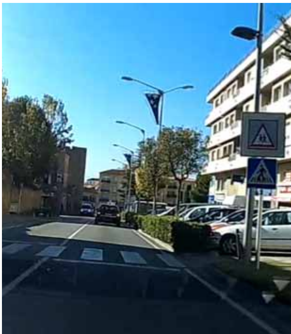
Senyalització de pas de vianants reforçada amb un senyal d'entorn escolar lluminós
