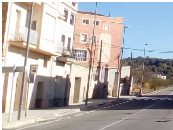
Parada amb pal (C-43) i sense espai reservat per al bus
