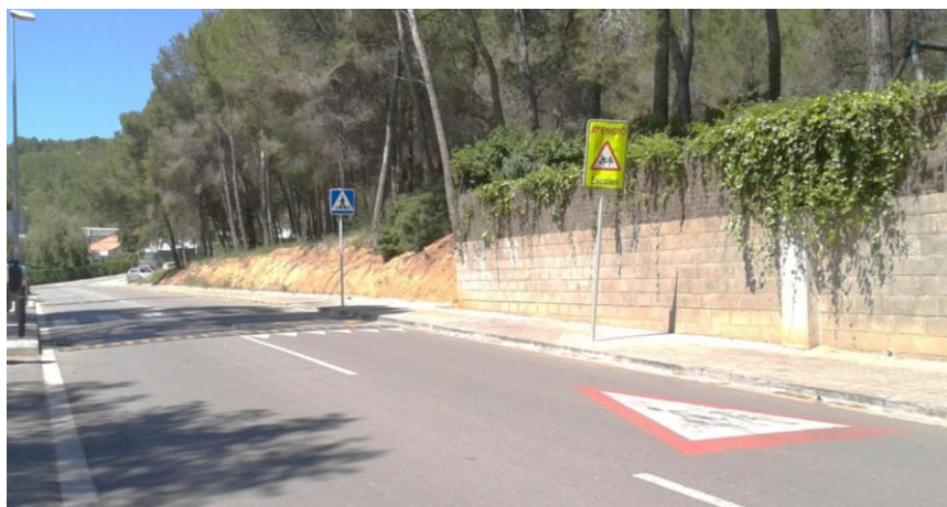
Figura 7: Senyalització vertical i horitzontal de reforç (Castedefells)
