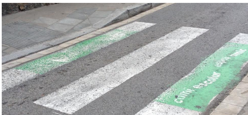
Figura 6: Senyalització del Camí Escolar en mal estat: Escola Montseny
