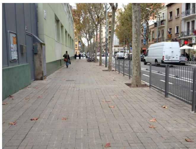
Figura 29: Carrer Pujades: accés i carril bici (escola Les Acàcies)
