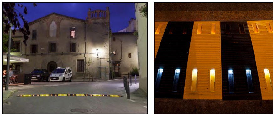
Fig. 9: Bandas reductoras de material rígido que incorporan iluminación.
