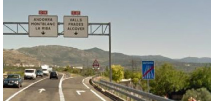
Senyalització de canvi de tipus de via no reforçat amb una limitació de velocitat.
