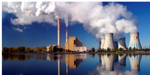
Imatges 3 i 4. Central termoelèctrica
